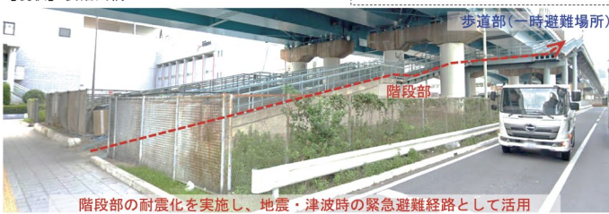
【現状】安治川橋
