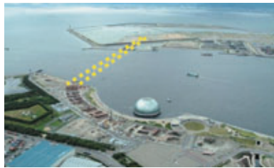
夢洲トンネル
