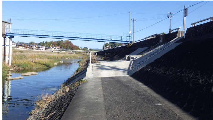
図 4.2.1 フラップゲート化した樋門（瀬古口第2排水樋門）
