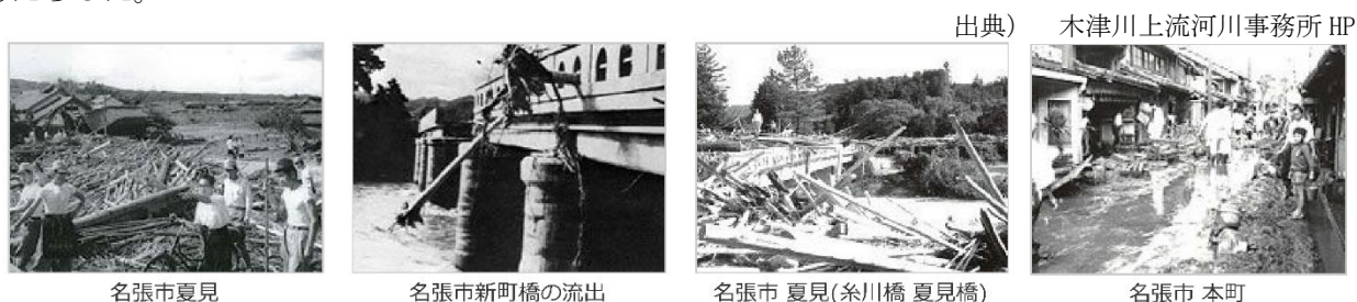
図 1.3.9 昭和34年9月の伊勢湾台風による被災状況
