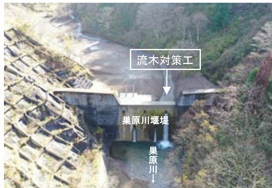
巢原川堰堤改築（令和5年12月時点）
