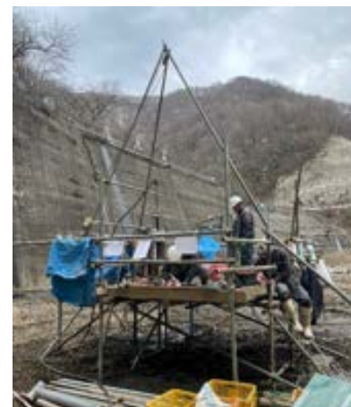
地質調査の状況（令和5年撮影）
