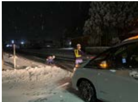
道路パトロール(路面状況確認)
