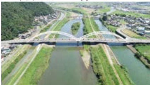
北川下流部(水取地区付近)
