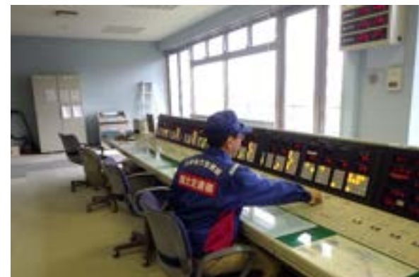
堰の操作システムの点検の様子
