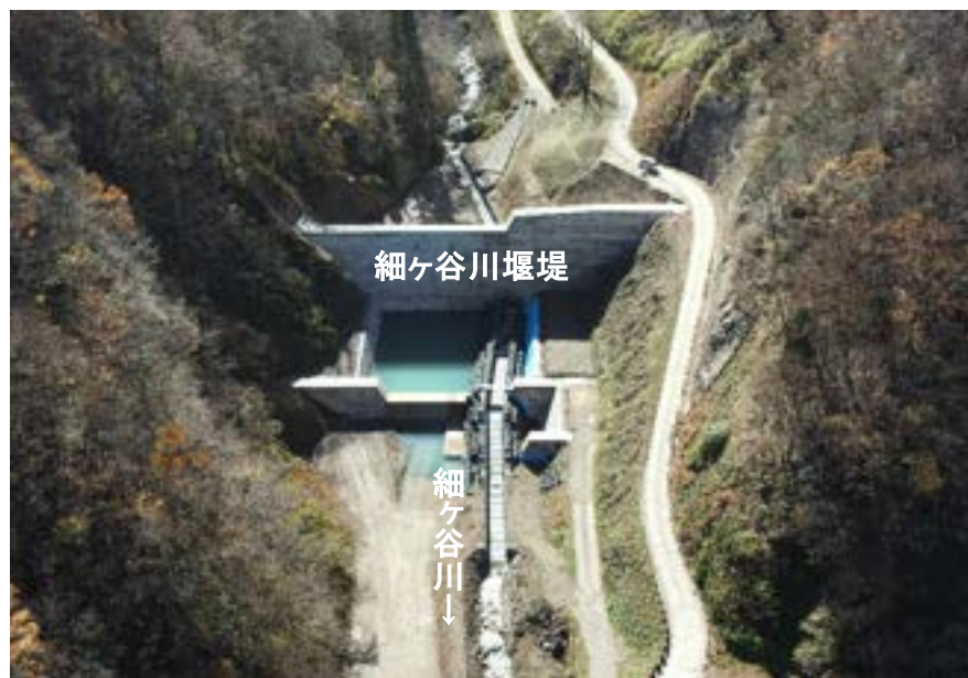
細ヶ谷川堰堤（令和5年12月時点）
