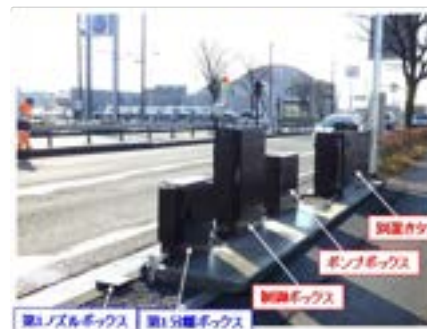
酢酸系液状凍結防止剤散布装置
