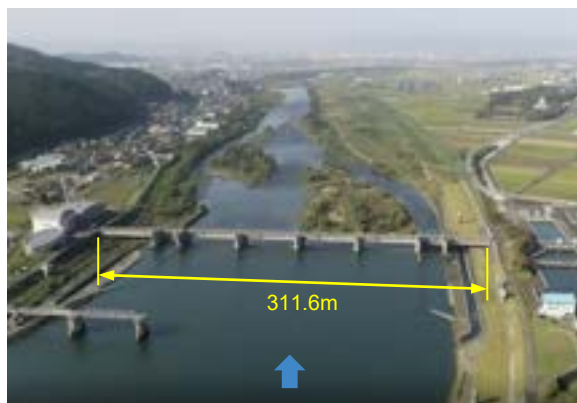
九頭竜川鳴鹿大堰(下流を望む)
