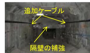
既設橋にて、PC鋼材の腐食発生を受け、PC桁内に外ケーブルを追加配置した例
