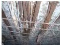
PC鋼材の腐食例
