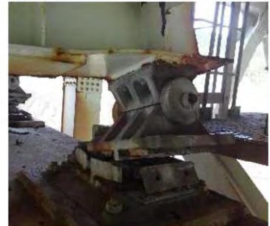
橋梁の支承・主桁の損傷
