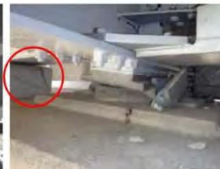
写真-6 支承の破損の状況
