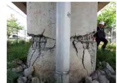
写真-7 段落し部の損傷
