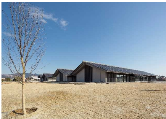
外観北西面（緑化）
